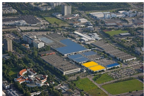
BMK-Standort im Sigmatechnopark Augsburg (STA)
